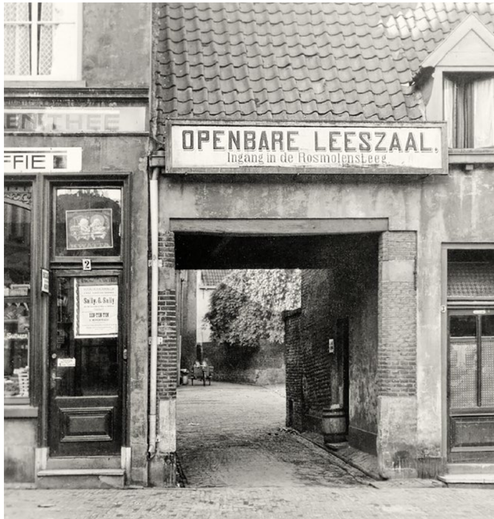
Winkel van Snatager, Rozengracht 2, links van noordelijke ingang Rosmolensteeg in 1938. Op de ruit L. Snatager. 'Zondag geopend'. In bovenlicht Kwatta-reclame. (NL-ZuRAZ, 0177-1091-0013).
