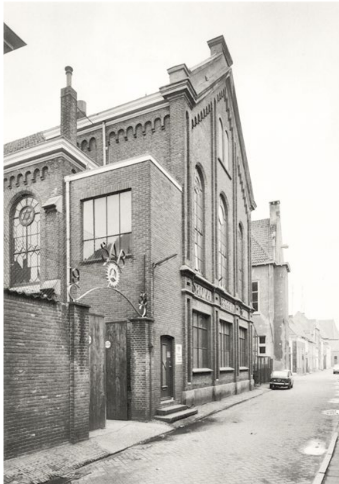
Dieserstraat. De synagoge verbouwd en vergroot tot fabriek. De naam Speciaal Apparaten Bouw op de voorgevel en het logo SAB boven de nieuw gebouwde poort. Begane grond voorzien van ramen.
